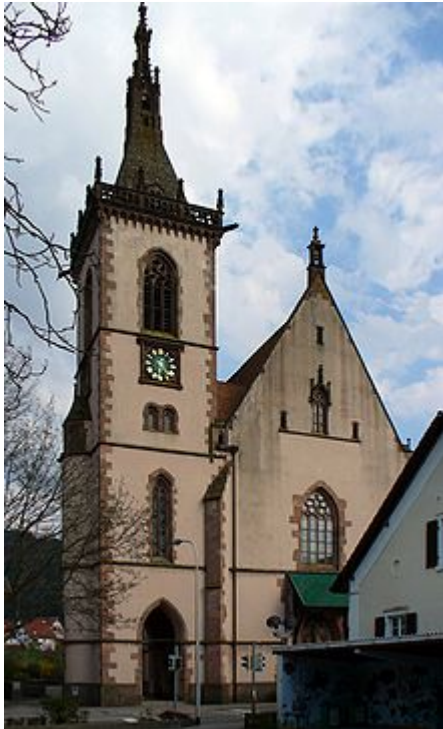
Wallfahrtskirche Mariä Krönung, Ansicht von Westen
